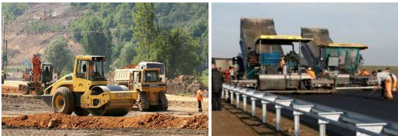
Слика 2. Радови на изградњи коридора X кроз општину Димитровград
