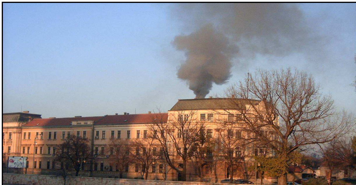
Слика 3: Извор аерозагађења, котларница зграде Универзитета
